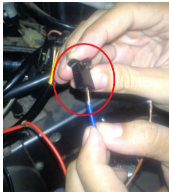
Gambar 6. Pemasangan Kabel Biru Ke Socket Pick-Up Coil
