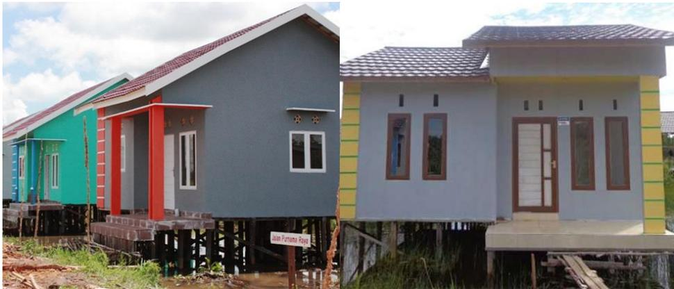
Gambar 2. Bangunan rumah konstruksi beton dengan pondasi tiang kayu
