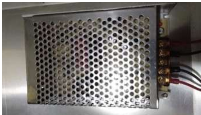
Gambar 13. Pemasangan Power Supply
